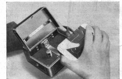
Einlegen der Kassette in die Siemens-Kino-Kamera
