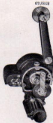
Bauer-Tongerät zum Schmaltonfilm-Projektor SELECTION als Durchgang-Gerät gebaut mit Ausgleich durch Schwungmasse.
